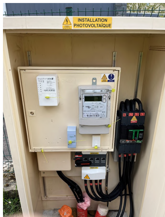
Coffret d'alimentation électrique supérieur à 36 kVA
