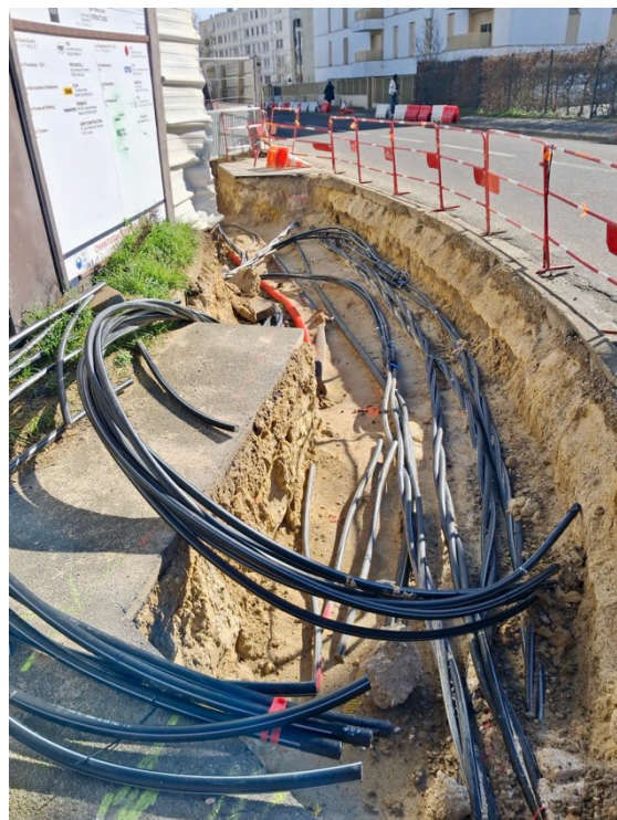
Modernisation du réseau HTA
