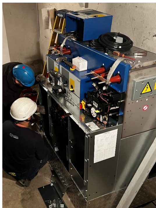
Modernisation d'un poste de distribution publique et renouvellement de câbles
