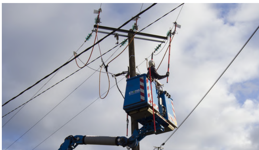
Intervention Enedis sur le réseau aérien HTA
