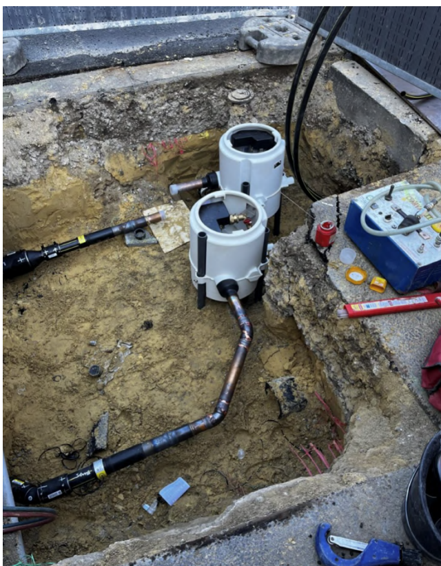
Pose de sous-carters et raccordements en cuivre.
