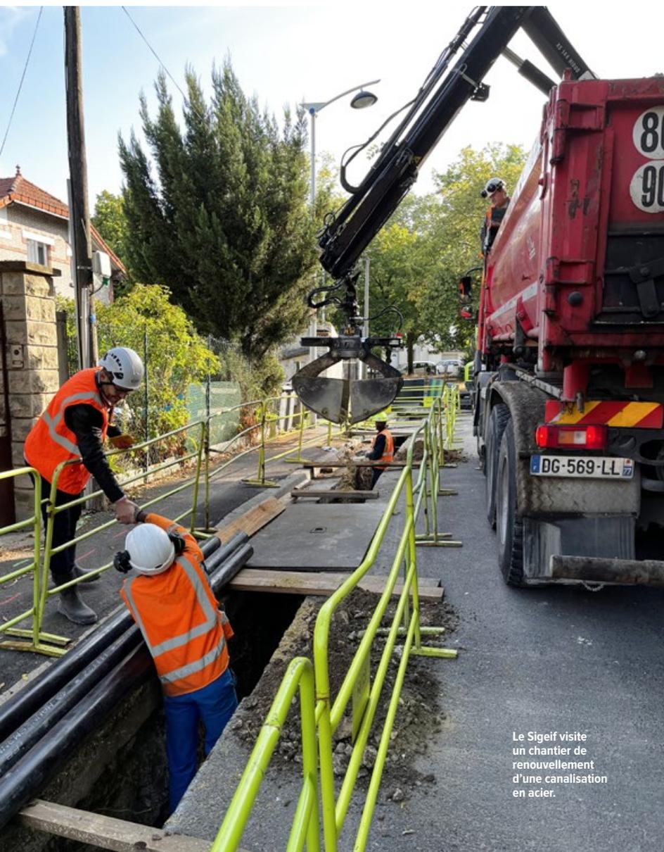
Le Sigeif visite un chantier de renouvellement d'une canalisation en acier.
