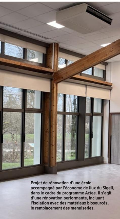
Projet de rénovation d'une école, accompagné par l'économe de flux du Sigeif, dans le cadre du programme Actee. Il s'agit d'une rénovation performante, incluant l'isolation avec des matériaux biosourcés, le remplacement des menuiseries.
