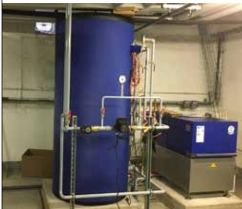
Vue de l'installation d'Antony, composée du module de micro-cogénération et d'un ballon-tampon de stockage.
